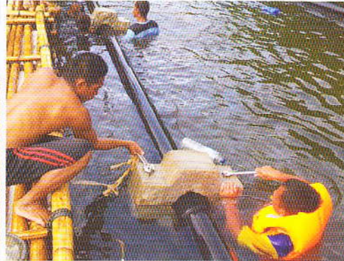
Instalasi Pipa Bawah Laut Kota Mamuju, Pulau Karampuang, Sulawesi Barat
