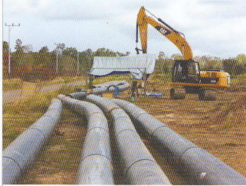
Proyek SDA Perpipa Air Baku Sungai Maro Merauke, Papua
