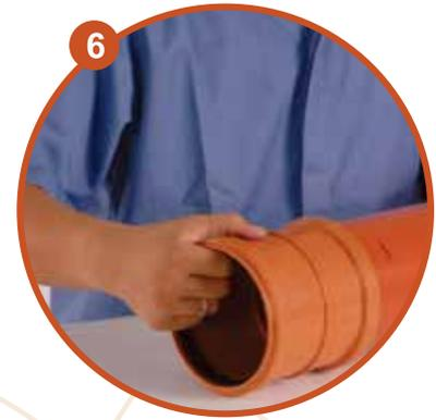
1. Berilah *chamfer* (sudut  $15^{\circ}$ ) pada *spigot* pipa yang akan disambungkan.
